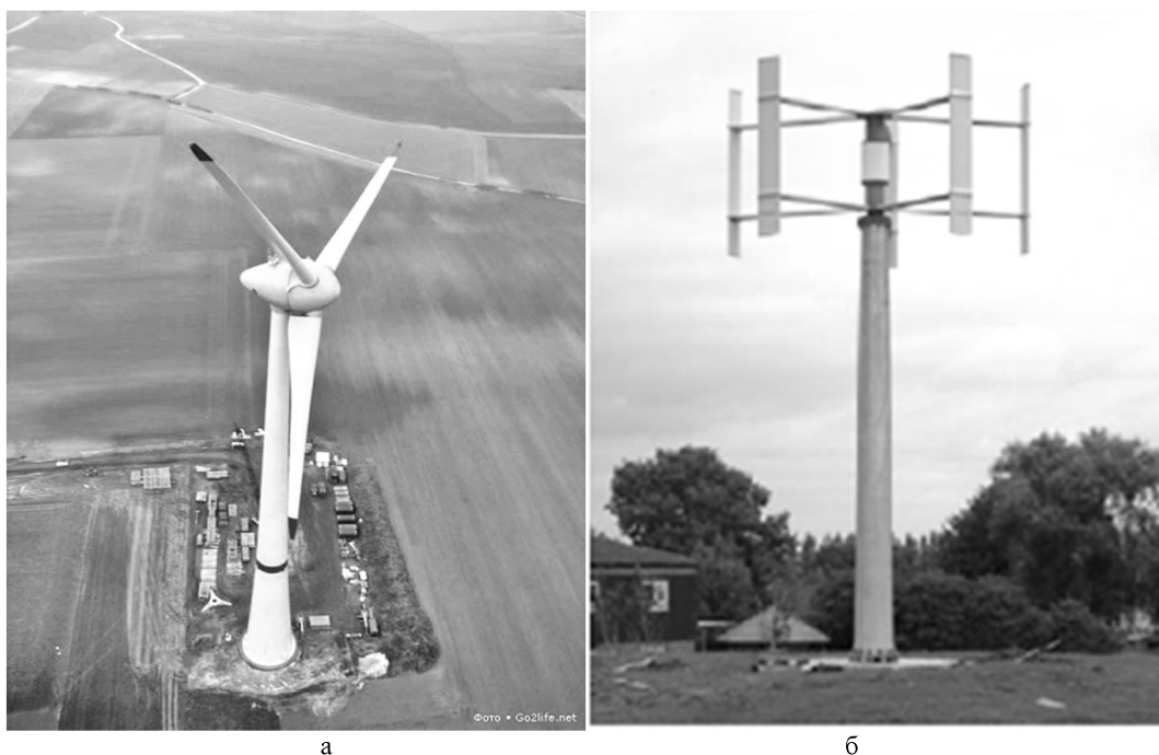
Рисунок 1 – Основные типы ветроэнергетических установок: а – горизонтально-осевая; б – вертикально-осевая, ротор Дарье
